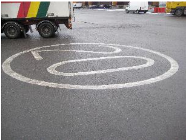
Figur 6:10 Hastighetsbegränsning i asfalten.
