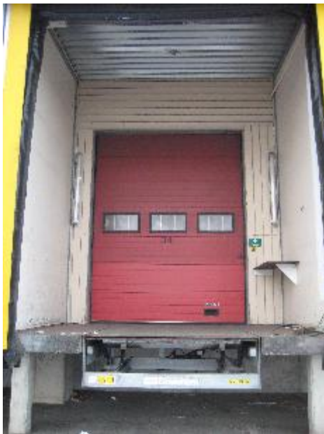
Port och sluss vid terminalen i Önnestad
